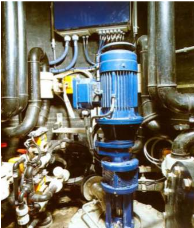
Exzentrerschneckenpumpe im Schacht
