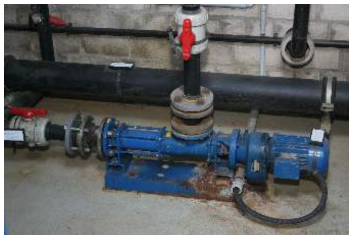
Allweiler® Exzentrerschneckenpumpe der Baureihe SEBP in der Grundwasseraufbereitungsanlage. Diese Pumpe führt die abgesetzte Wasserphase aus den Schlammvorlagebehältern nach einer festgelegten Absetzzeit in die Pumpenvorlage zurück.
