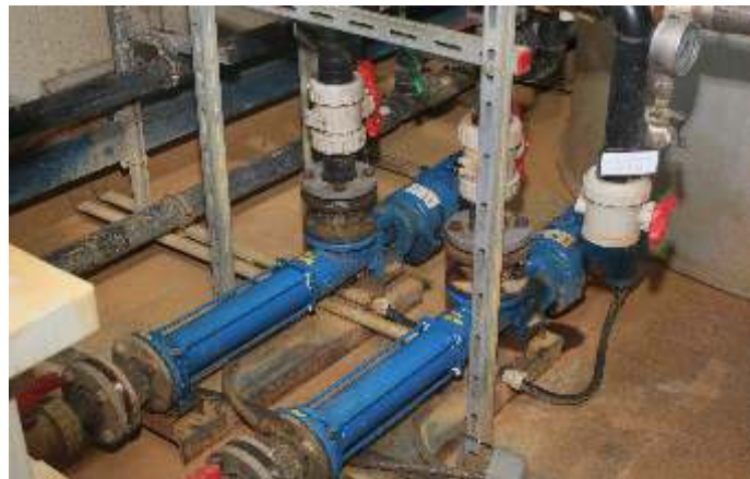
Die beiden ALL-OPTIFLOW® Pumpen zur Grundwasserförderung innerhalb des Sperrriegels
